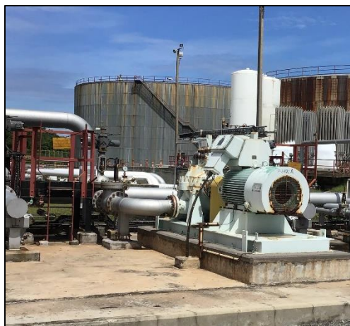
รูปที่ 2-1 Mechanical Seal บริเวณปั๊ม และอุปกรณ์
