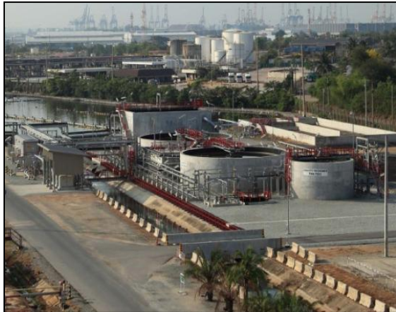
รูปที่ 2-14 ระบบ Activated Sludge (AS)
