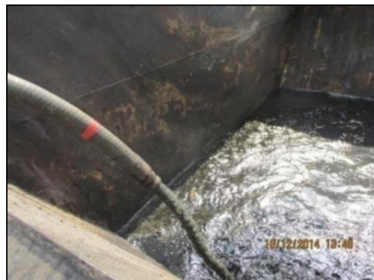
รูปที่ 2-21 การขุดลอกตะกอนในบ่อบำบัดปี พ.ศ. 2557
